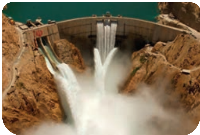
شکل ۳- سد و نیروگاه آبی کارون ۳ استان خوزستان
